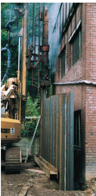
Sanierung Altlast Brohl-Lützing
