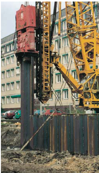
Sanierung Gulbener Straße, Cottbus
